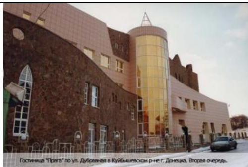
59. Гостиница «Прага» в г. Донецк (II-я очередь строительства по ул. Дубравная)
