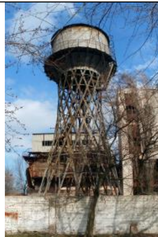
86. Водонапорная гиперболоидная башня системы В. Шухова в г. Часов Яр
