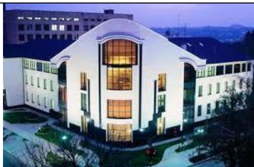
58. Здание «Индустриальный союз Донбасса» по ул. Щорса в г. Донецке
