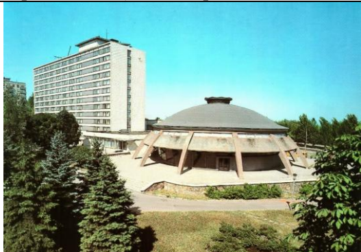
87. Объекты, возведенные в г. Донецке по проектам арх. Л. Я. Штейнфаера: 1 - гостиница «Шахтер» с пресс-центром
