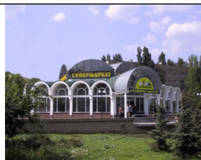
67. Универсам «Шахтер» шахты им. Засядько по пр. Ленинскому в Киевском р-оне г. Донецка
