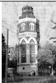
83. Водонапорная башня (1908-1910 гг., арх. Нильсен Виктор Александрович)
