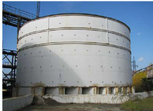
Общий вид обследуемого резервуара
