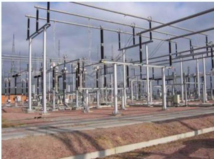
Конструкция жесткой ошиновки в открытых распределительных устройствах
