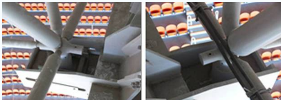
Инструментальный контроль перемещений опорных узлов структурного блока покрытия
