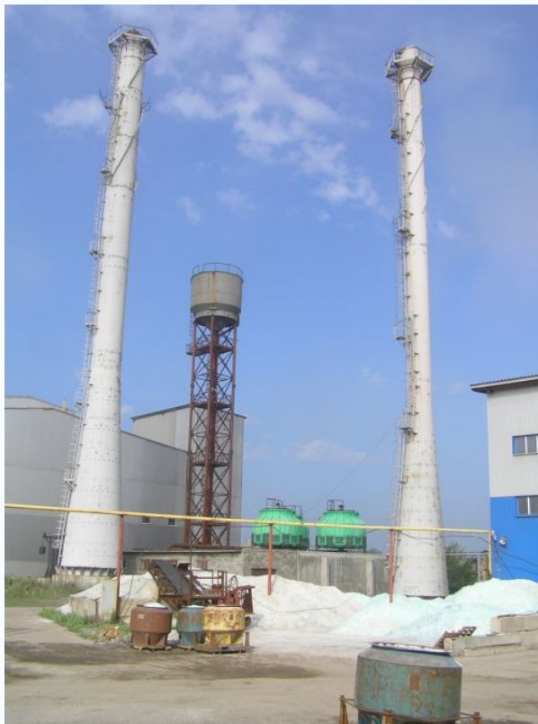
Дымовые трубы Н=50 м, Н=60 м, водонапорной башни 150 м 2
