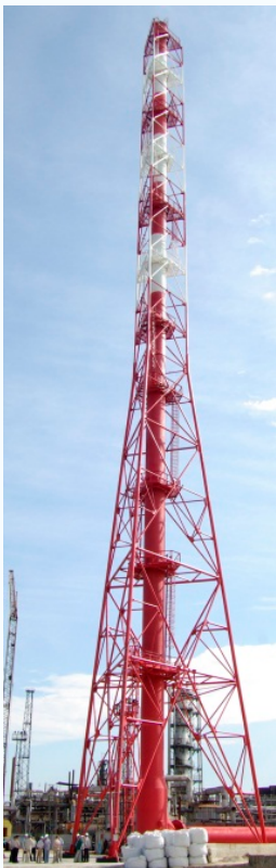
Дымовая труба 120 м
